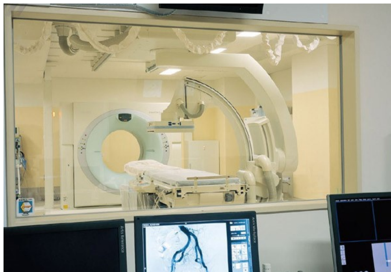
Figura 4 – Fotografia panorâmica de um ambiente para diagnóstico médico destacando as janelas de vidro para proteção radiológica.
